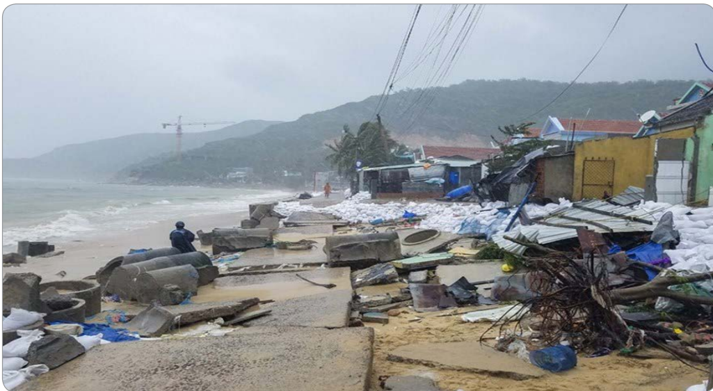
Hình 6.5. Bờ kè biển chắn sóng Nhơn Hải, TP. Quy Nhơn bị hư hỏng sau cơn bão số 5 năm 2019
