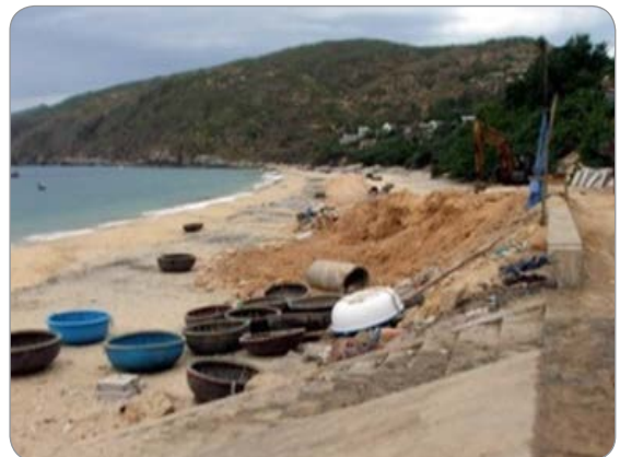
Hình 6.16. Gia cố một đoạn bờ biển xã Nhơn Lý, TP. Quy Nhơn bị sạt lở (Ảnh: Viết Hiền)
