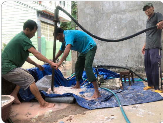
Hình 6.13. Người dân xã Mỹ Châu, huyện Phù Mỹ khoan giếng để tìm nguồn nước sinh hoạt (Ảnh: Nguyễn Linh – TTXVN)
