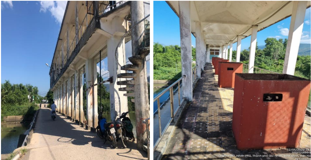
Hình 10: Một số hình ảnh khảo sát tại công trình ĐNM Phú Xuân
