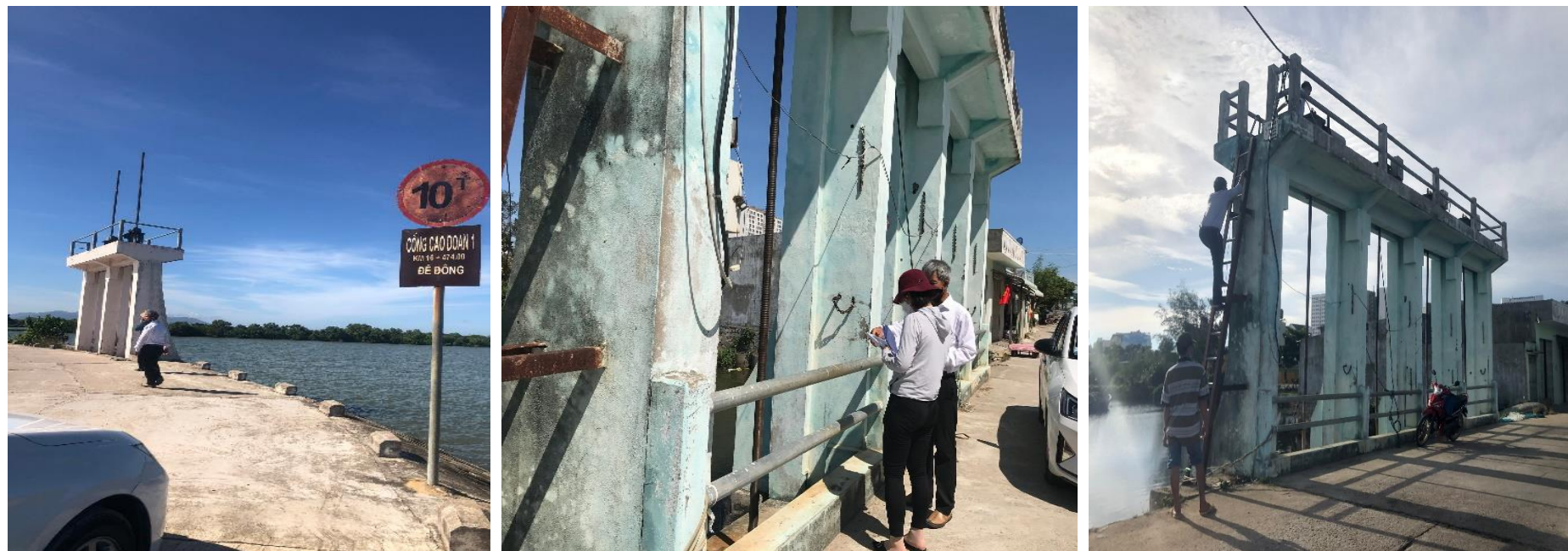
Hình 3: Một số hình ảnh công trình Cổng trên tuyến đê Đông
