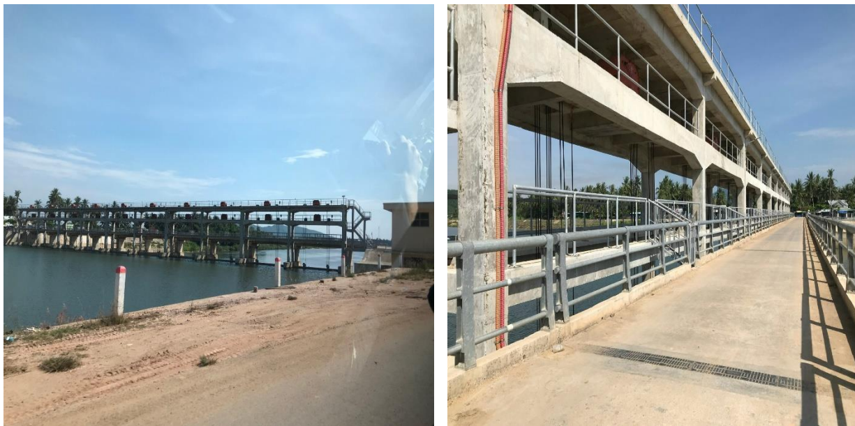
Hình 4: Một số hình ảnh khảo sát tại công trình ĐNM sông Lai Giang
