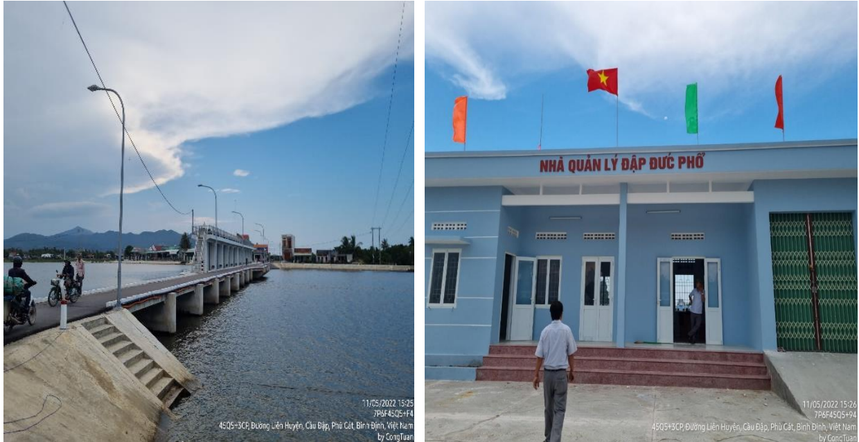
Hình 6: Một số hình ảnh khảo sát tại công trình ĐNM Đức Phổ
