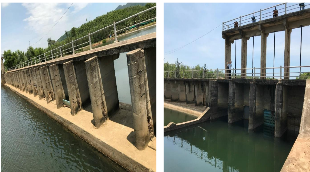
Hình 5: Một số hình ảnh khảo sát tại công trình ĐNM Trà Ô
