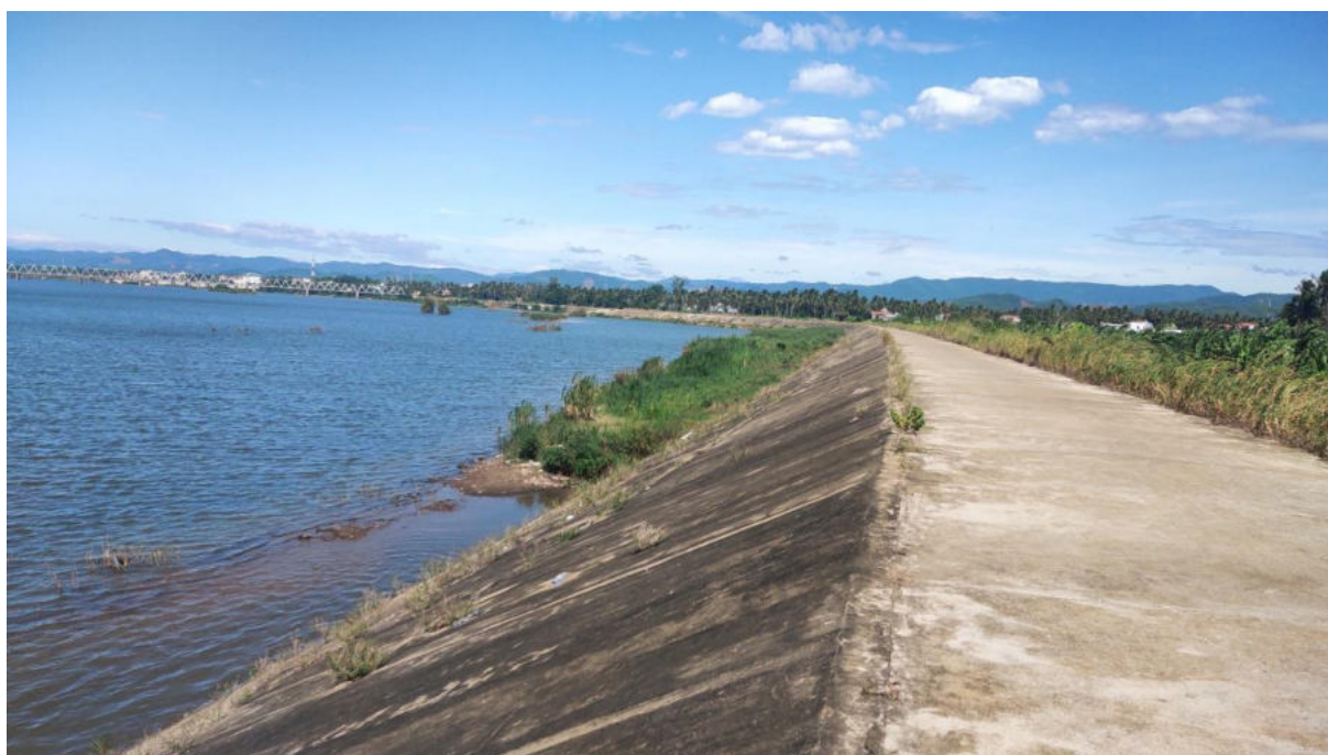
Hình 2.2 Hiện trạng khu vực khai thác tại thời điểm lập đề án đóng cửa mở nhìn từ bờ sông phía Bắc khu vực khai thác
