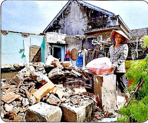
Hình 6.3. Nhà người dân ở huyện Tuy Phước bị sập sau cơn bão số 5, năm 2019
