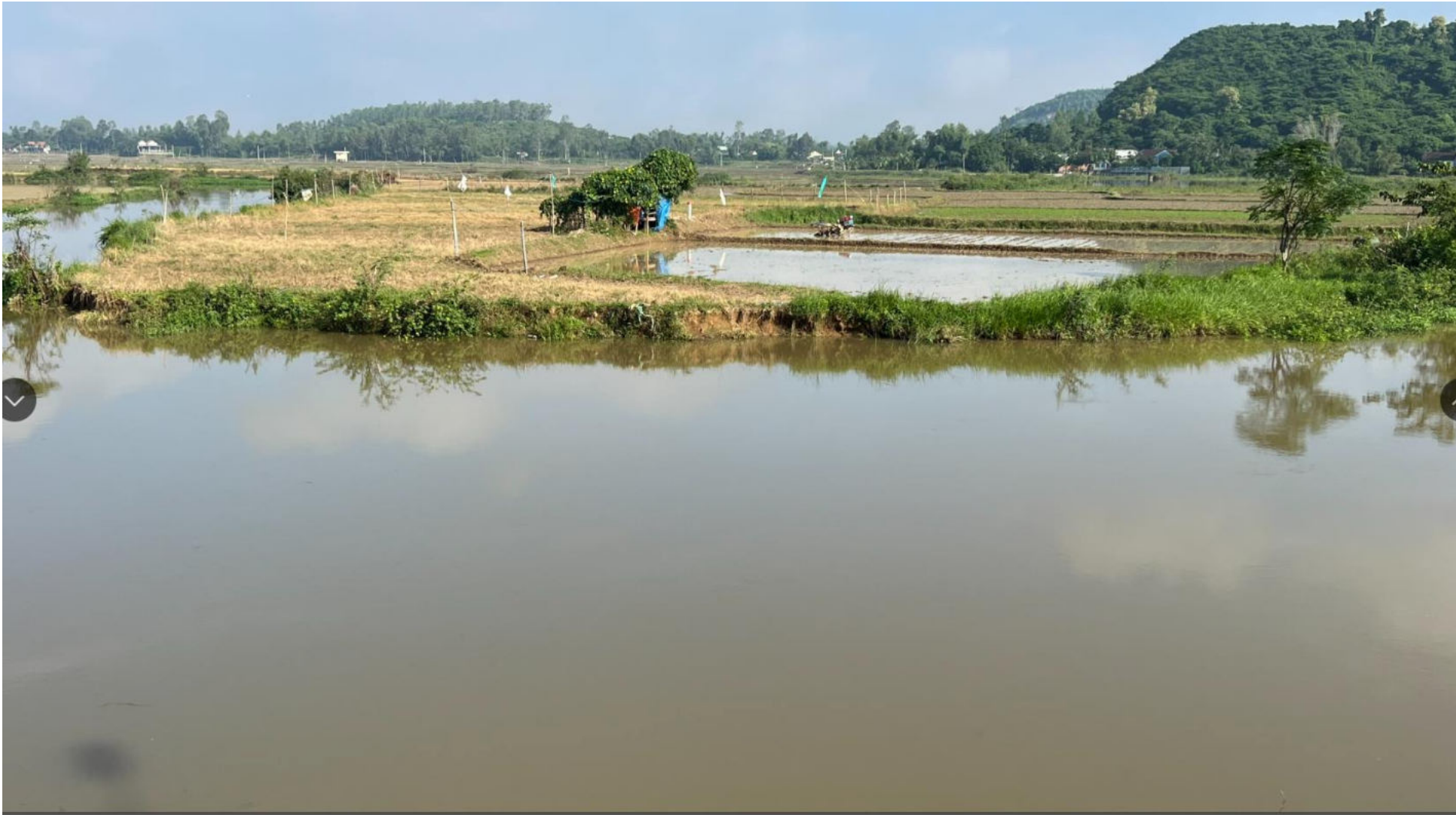
Sạt lở 2 bên bờ sông La Vỹ, đoạn qua xã Cát Tường
