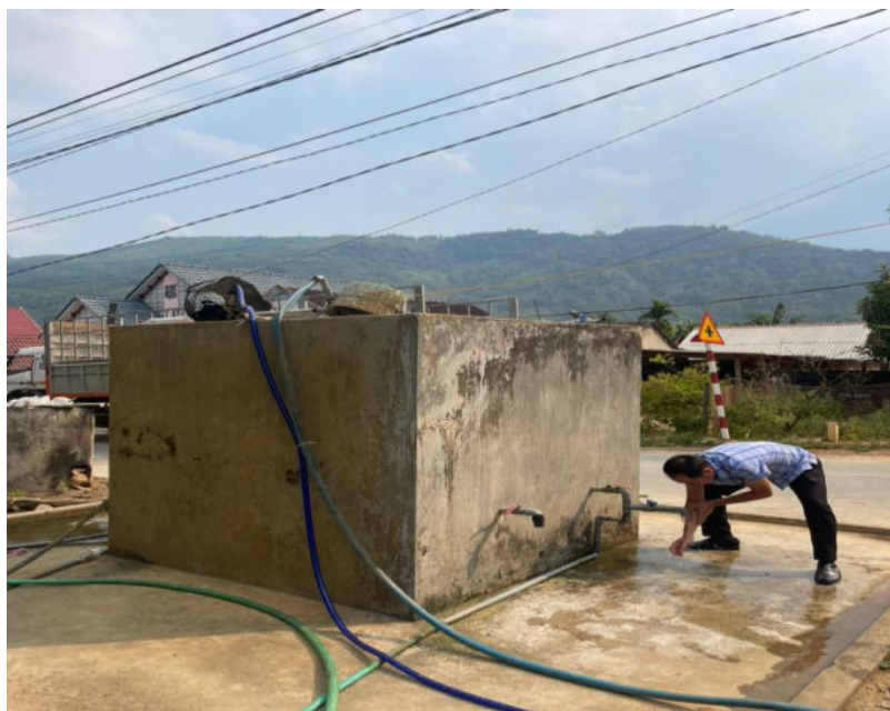
Hình 4: Bể chứa công cộng làng O6, người dân tự lắp bơm nước về nhà
