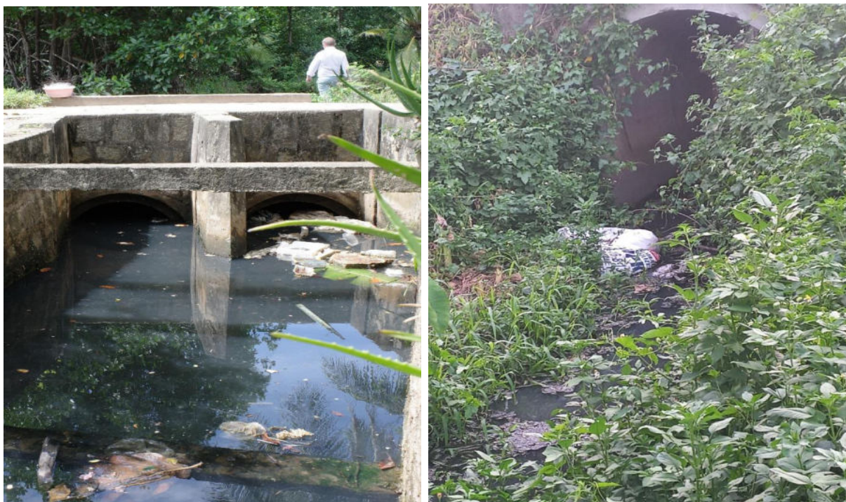
Hình 8: Công thoát nước thải phường Bồng Sơn
