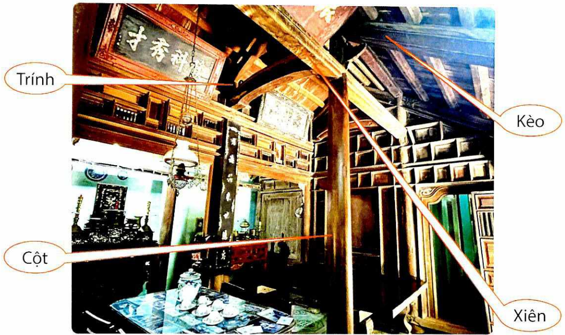
Hình 5. Kết cấu gỗ của ngôi nhà lá mái Bình Định
